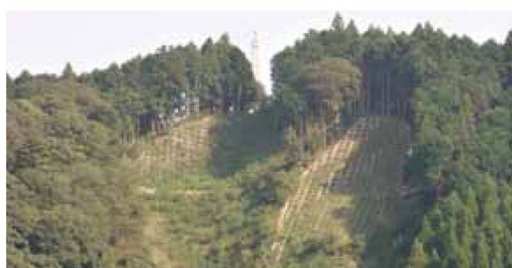
向山復旧治山事業(浜松市天竜区春野町堀之内)
