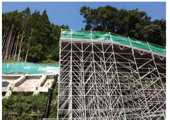
西川急斜地崩壊対策事業(浜松市天竜区籠山町大嶺)
